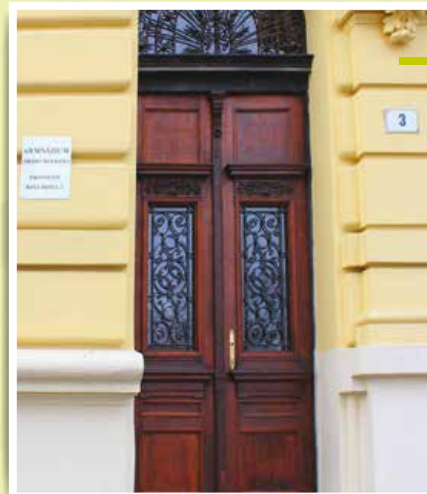
Hlavní vchod Gymnázia J. Wolkerova (výměna vstupních dveří v roce 2012).
